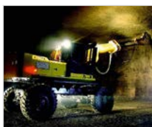
土木工程和采矿
